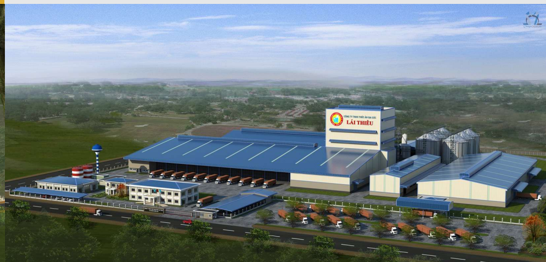
NHÀ MÁY THỨC ĂN GIA SÚC LÁI THIỆU LAI THIEU FEEDMILL
